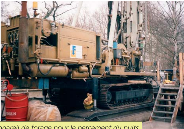
Appareil de forage pour le percement du puits S3 à Bad Schinznach (photo F.-D. Vuataz)
