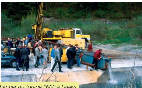
Chantier du forage P600 à Lavey-les-Bains (photo F.-D. Vuataz)
