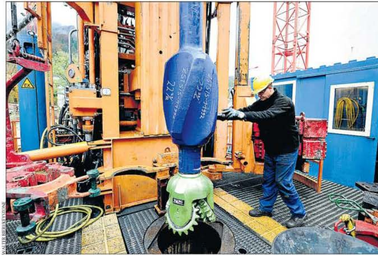
Forage exploratoire dans le quartier de Triemli, à Zurich. Le projet devait notamment servir à chauffer l'hôpital, mais faute d'avoir trouvé de l'eau à un débit suffisant il est au point mort. ARCHIVES
