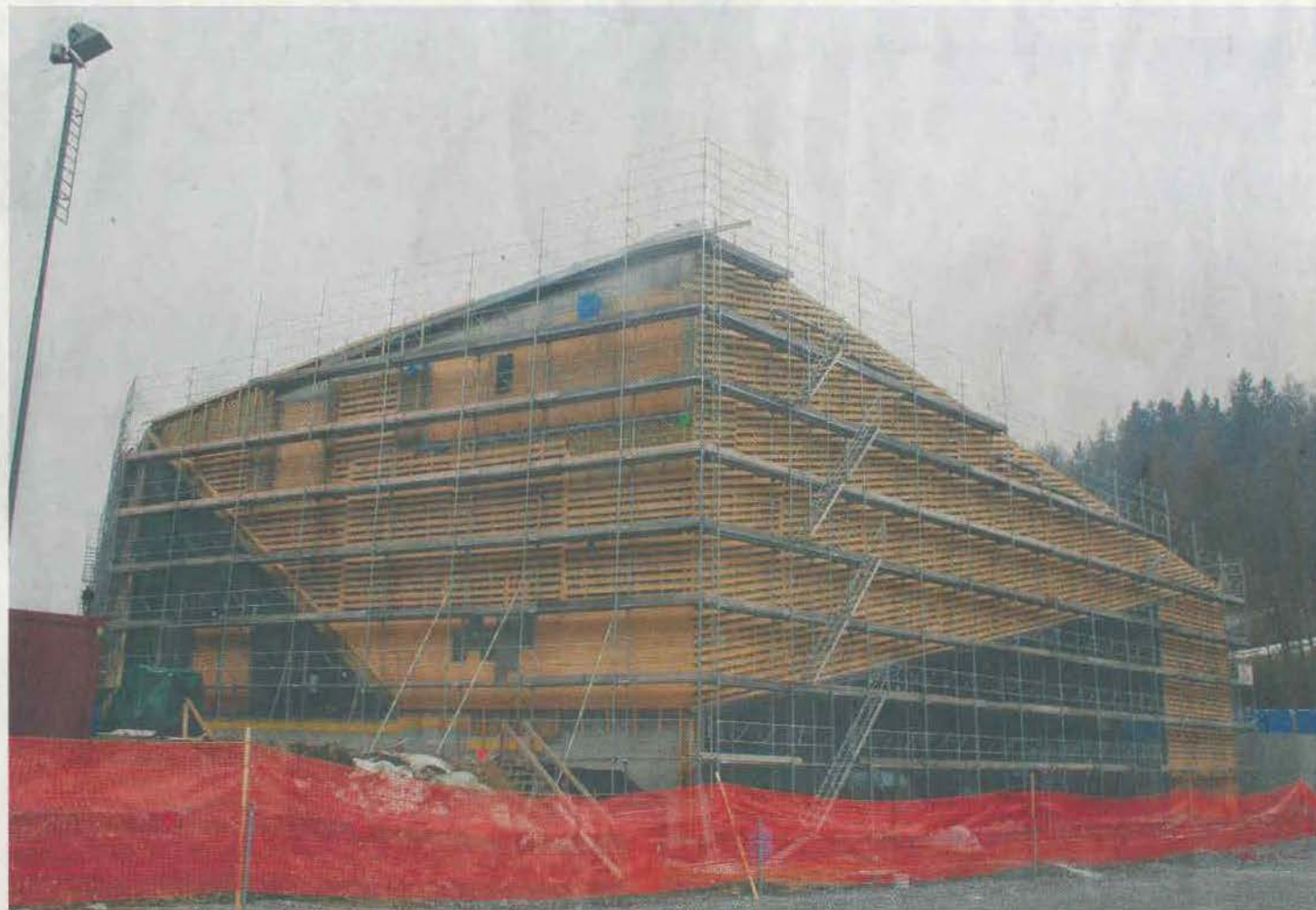
La commune de Bagnes doit encore approfondir les études de faisabilité avant d'envisager la possibilité de chauffer avec de l'énergie géothermique la future salle multifonctions de Saint-Marc au Châble. LE NOUVELLISTE
